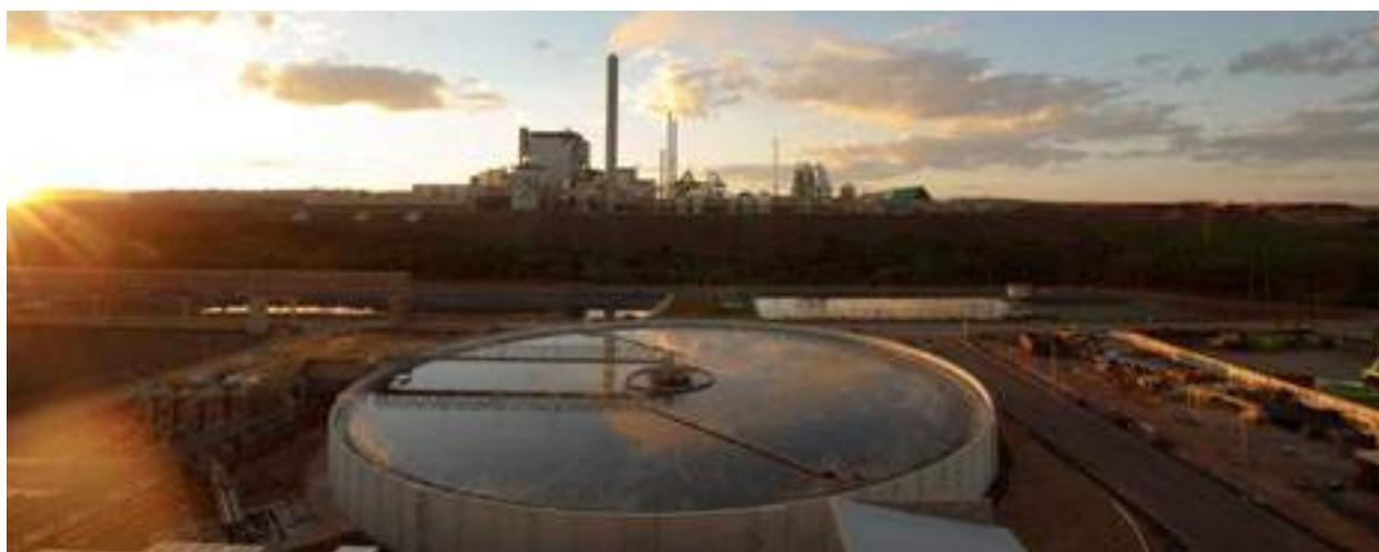
Secagem de lodos: instalação de uma planta de secagem de lodos oriundos do tratamento de efluentes, atualmente em andamento na Unidade Puma. Além de reduzir os volumes de lodo biológico e lodo terciário a serem tratados, traz a oportunidade de utilizar o lodo seco como combustível para a queima na caldeira de biomassa.
